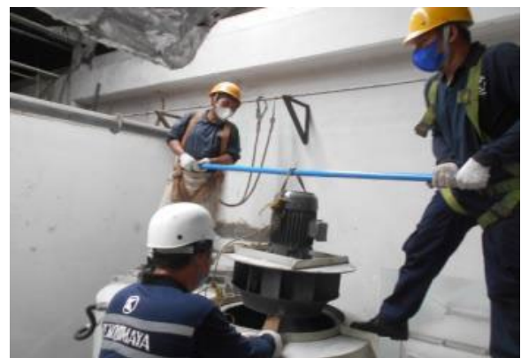
Fig. 4. Dismantling fan
